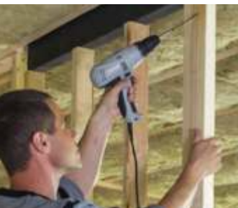
O processo de instalação de paredes em Drywall começa com estrutura em madeira, revestimento para isolamento, aplicação das placas de gesso e finalmente a pintura
