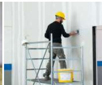
O processo de instalação de paredes em Drywall começa com estrutura em madeira, revestimento para isolamento, aplicação das placas de gesso e finalmente a pintura
