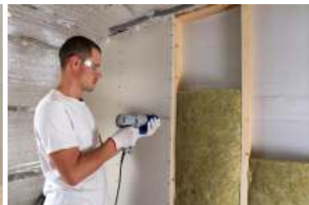
O processo de instalação de paredes em Drywall começa com estrutura em madeira, revestimento para isolamento, aplicação das placas de gesso e finalmente a pintura
