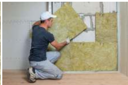
O processo de instalação de paredes em Drywall começa com estrutura em madeira, revestimento para isolamento, aplicação das placas de gesso e finalmente a pintura
